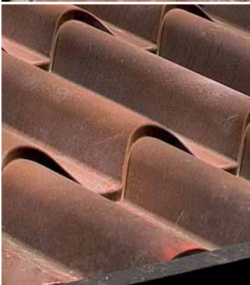
Dettaglio della copertura
